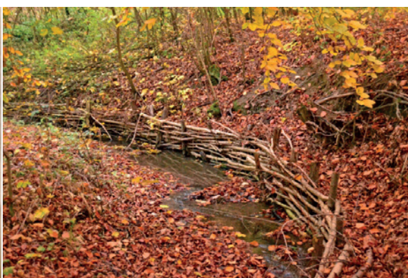
Fascines dans le Ruisseau de Nanry
